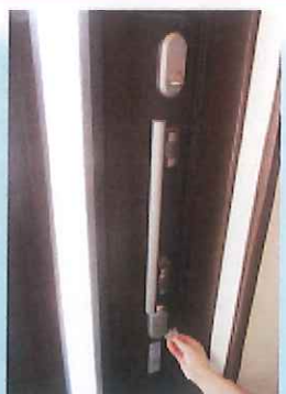
玄関ドア（内側）二重ロック ※飛び出し防止の機能あり
